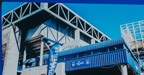
Le Palais des Sports vu de l'extérieur
